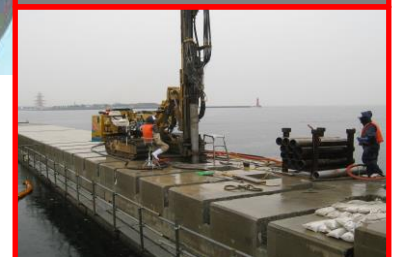
【岸壁・護岸補強アンカー】
