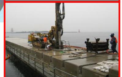
【岸壁・護岸補強アンカー】
