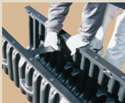
④突き当てアングルの取付け (下から斜に上げて取り付けてください)
