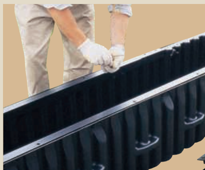
⑤重ね合せ部をボルトで 締付ける
