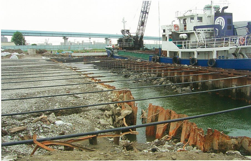
港湾控索施工
