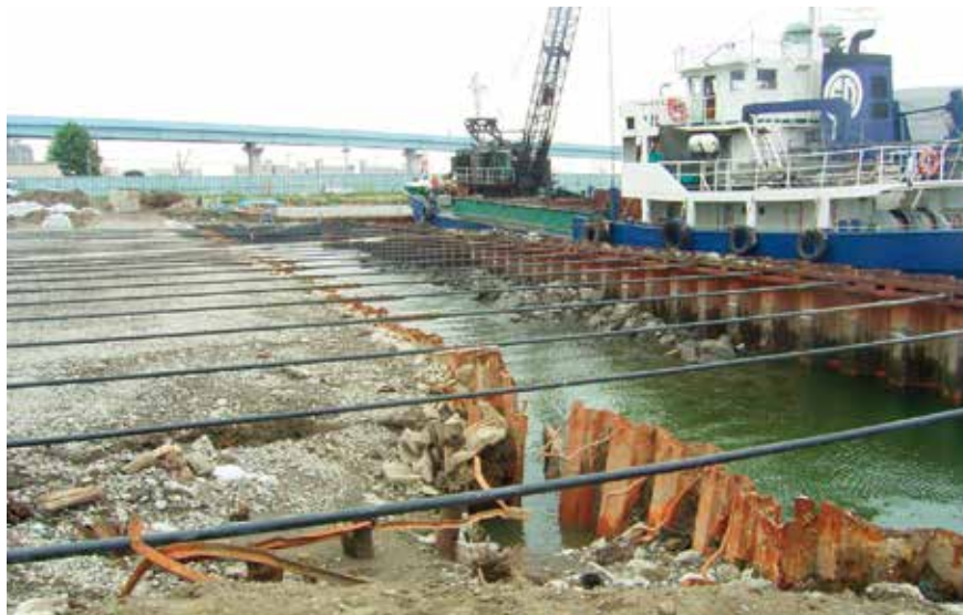
港湾控索施工
