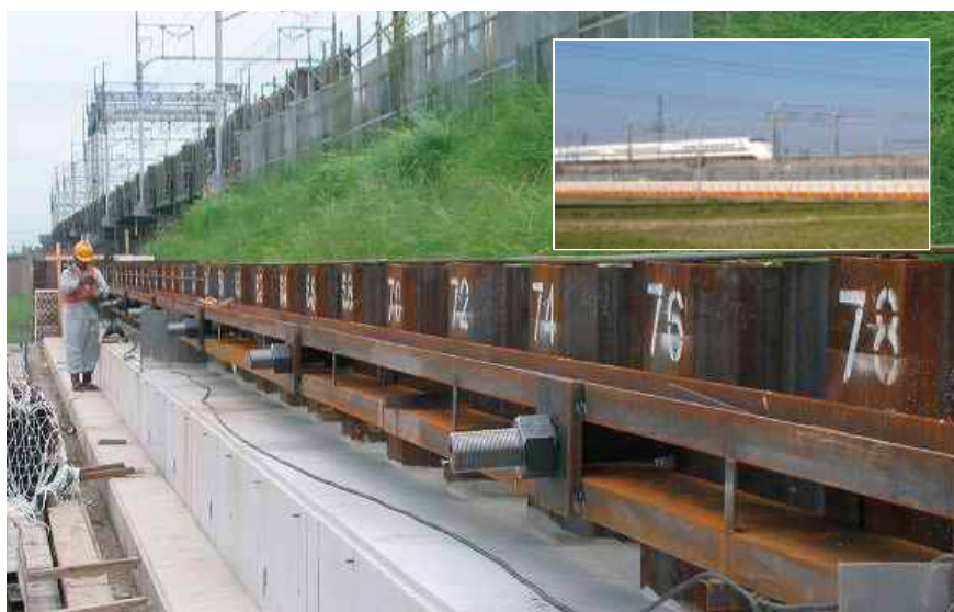
新幹線耐震盛土
